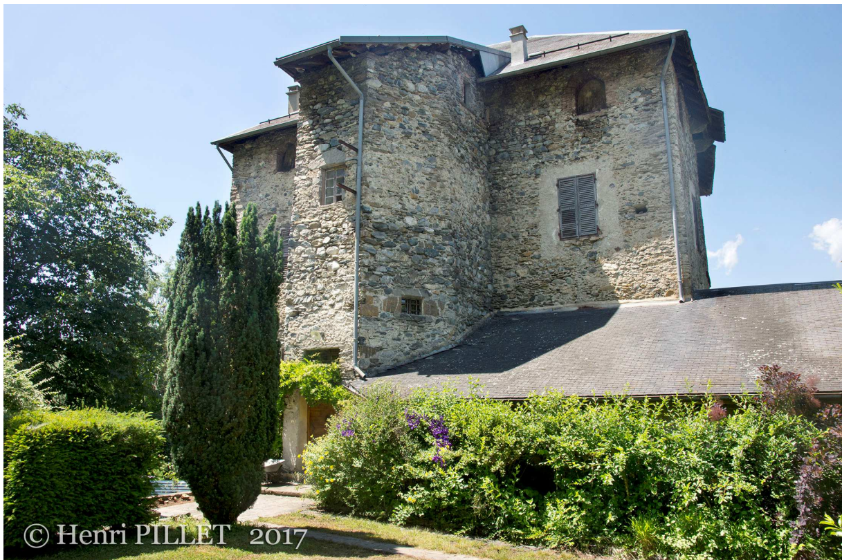
La maison forte de Villard-Dizier, demeure ordinaire des Nobles de Gallis
